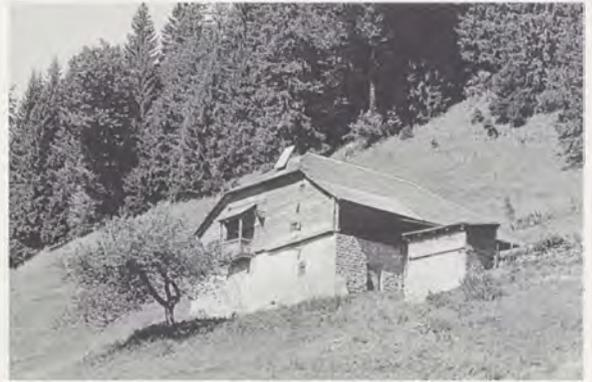
Deux *caves* avec accès latéraux. Celle située à l'est comportait une voûte, remplacée plus tard par un plafond en béton. La *cuisine* centrale est flanquée à l'est de la *chambre à lait*, à l'ouest d'une chambre. Un petit balcon, protégé par un auvent, se trouve sur la façade pignon *tavillonnée*. Un mur de l'âtre protège la paroi en bois.
