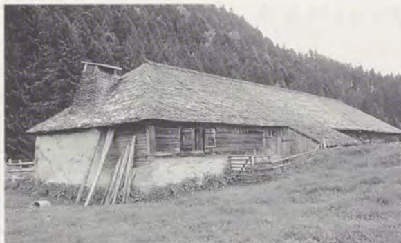
La porte de la *cuisine* jouxte celle de l'étable. Le creux à feu est posé contre un pan de mur pignon construit ultérieurement. La borne perce le pan rabattu. Une porte donne dans l'étable. La chambre a été lambrissée et les fentes d'aération bouchées. Les fenêtres sont récentes.
