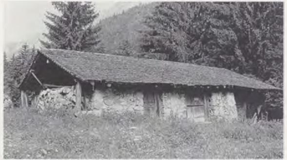
Der *Doppelstall* weist auf der Innenseite Futterkrippen, auf der Aussenseite nur einen Anbindebalken auf. Darüber befinden sich drei vermauerte Schartenöffnungen. Eine Bauinschrift («1725 CB») ziert den Sturzriegel über dem östlichen Stalleingang.
