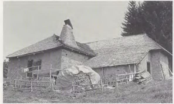
On entre dans l'étable face à la porte extérieure. La *chambre à lait* est aérée par des ouvertures verticales ébrasées. Un escalier a été pratiqué dans la partie arrière de ce local. L'étable double est éclairée par deux fenêtres. Un angle a été remplacé par une paroi en planches. La *toiture*, de forte pente (44°), repose sur une charpente triangulaire, stabilisée par un faux entrain.
