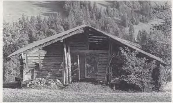
mauer aus Bruchsteinen. Querlaufende Läger für Gross- und Jungvieh. Rückwärtiger Futtergang mit Heuabwurfloch. OG und DG: *Heuscheune*. Blockverband mit Gimwand (Zwischenräume durch Klötzchen unterstützt). Giebelwand durch zwei Kreuzständer (s. Abb. 82, S. 79) und einen Mantelstud mit Inschrift: BL ISB STB ZM HB 1782 (Abb. 621, 622) unterteilt. Rückwärtiges Heutor mit Erdrampe. Einseitig Bretterschlag-Laube. Reines, flachgeneigtes (20°) *Pfettendach* mit First- und zwei Mittelpfetten.
