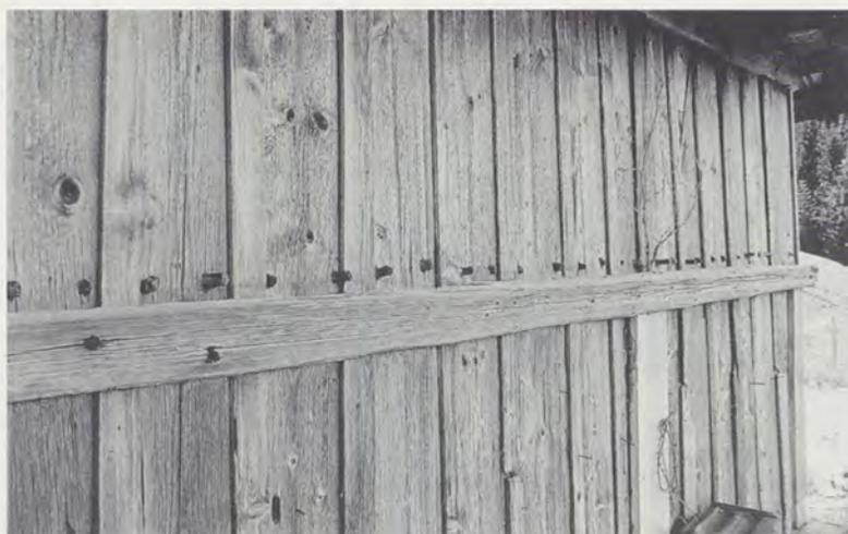
ein Fusspfettenverband von zwei bis drei «gewetzten» Kanthölzern (Abb. 79). Diese sollen dem schwergewichtigen Walmdach an seiner Basis genügend Festigkeit verleihen. Die Gimmwand ist ein locker gefügter Balkenverband an Heuscheunen, der mit seinen Zwischenräumen eine bessere Belüftung gewährleistet (Abb. 78). In den Längsschlitzn stecken Holzklötzchen.
