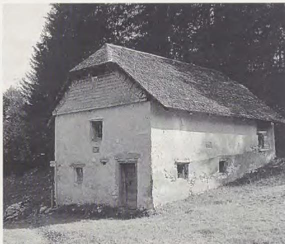
Toutes les fenêtres sont grillagées (fig. 590) et partiellement fermées par des volets. Certaines disposent d'un linteau en dalle ou sont accompagnées de fentes d'aération supplémentaires. L'intérieur du saloir est tapissé de tablars à fromages sur les quatre parois (fig. 123, p. 100). La porte du saloir est parsemée d'initiales; le linteau, chanfreiné en accolade, porte la date gravée de 1784.
