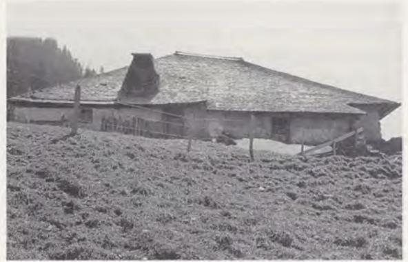
L'étable principale occupe la moitié du plan en longueur. Elle est accessible par un portail placé sous un rehaussement du toit. Une autre étable, munie de crèches, est installée en parallèle dans le prolongement de la cuisine. La façade nord a été remplacée en grande partie par un mur en béton percé d'ouvertures modernes.
